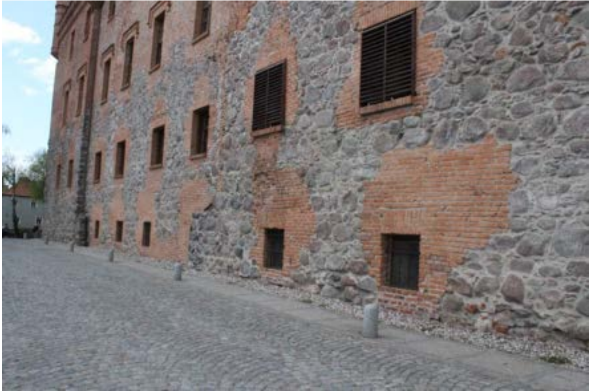
(fot. 55) Wyeksponowane szczegóły zachowanych ścian zewnętrznych zamku w Rynie, zdjęcie własne, maj 2019.
